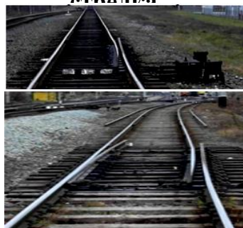
Рисунок 26 Сбрасывающие стрелка и остряк
