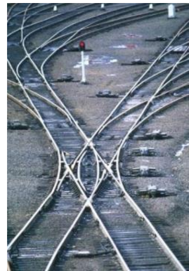
Рисунок 20 Перекрёстный стрелочный перевод
